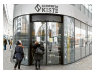
Nach einem Wasserschaden zog die „Schwarze Kiste“ im Februar aus. Die Ladenfläche wird neu genutzt. Foto: wys
