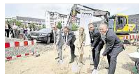
Ein Autohaus entsteht: Petra Roth und die Audi-Chefs graben die ersten Löcher.
