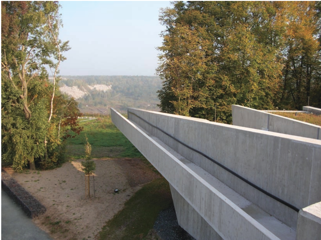
Abbildung 15-2: Zugang zur Plattform
