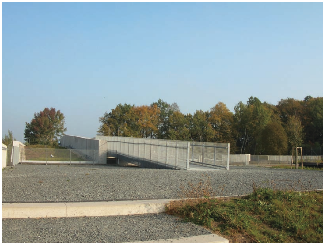
Abbildung 15-3: Steg zum Dach
